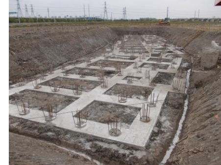
↑图 专家公寓 4#楼桩基锚固筋安装。
