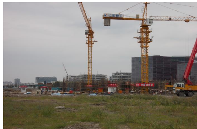
图↑ 本科生宿舍楼施工全景图 (图/文 孟祥鑫)
