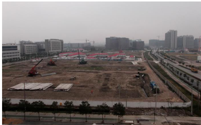
图↑ 生命学院桩基施工全貌。(图/文 程伟)
