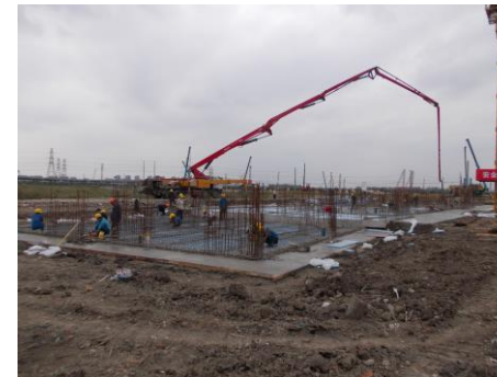
↑图 本科生 3#楼一层底板垫层浇筑。
