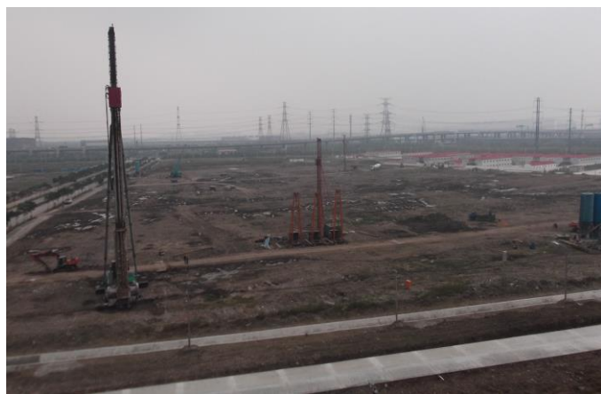
图↑ 物质、创艺学院桩基施工全貌。(图/文 程伟)
