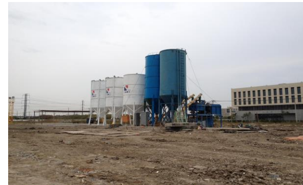
图↑ 学院区三轴搅拌桩搅拌站 基坑围护设备进场安装 图 → 学院区大基坑围护施工准备
