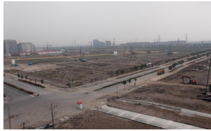
图↑ 信息、创管学院桩基施工全貌。(图/文 程伟)
