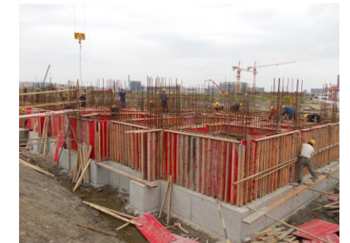
↑图 专家公寓 2#楼基础剪力墙封模施工。
