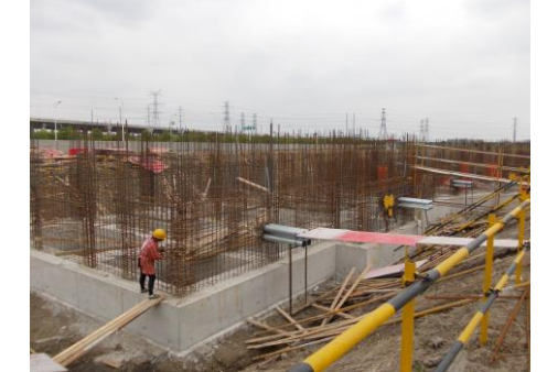
↑图 专家公寓 5#楼基础剪力墙钢筋绑扎。
