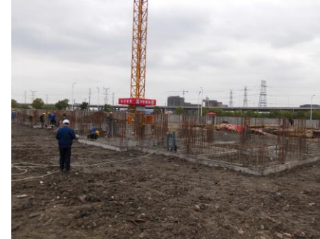
↑图 专家公寓 3#楼基础回土完成。
