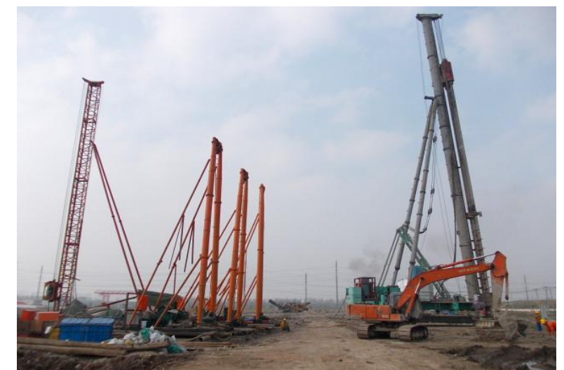
↑图 专家公寓 4#楼桩基锚固筋安装。
