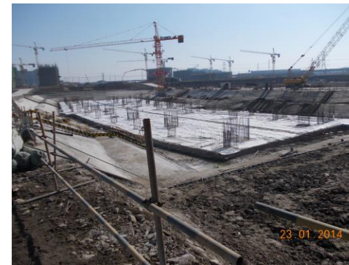
↑图 2-1, 2-2 块混凝土底板浇捣完成
