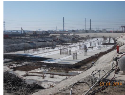
↑图 5-1, 5-2 块混凝土底板浇捣完成
