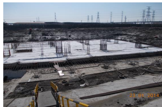
↑图 3-3 块混凝土底板浇捣完成
