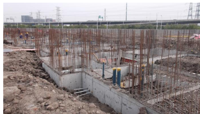
↑ 专家公寓及教师宿舍 5#楼基础土方回填。
