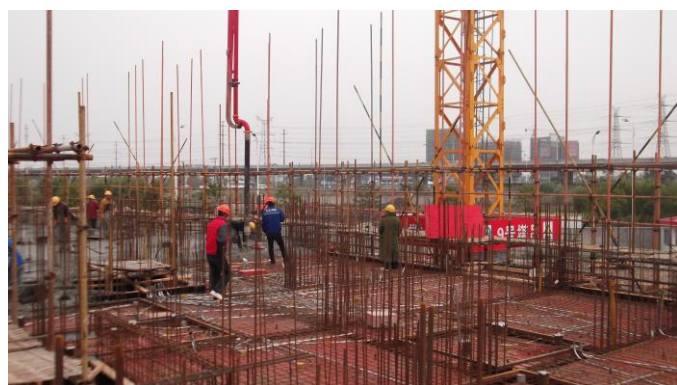
↑ 专家公寓及教师宿舍 3#楼一层顶板混凝土浇筑。
