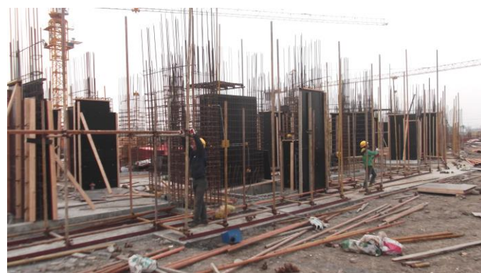
↑ 专家公寓及教师宿舍 2#楼一层剪力墙、柱钢筋绑
