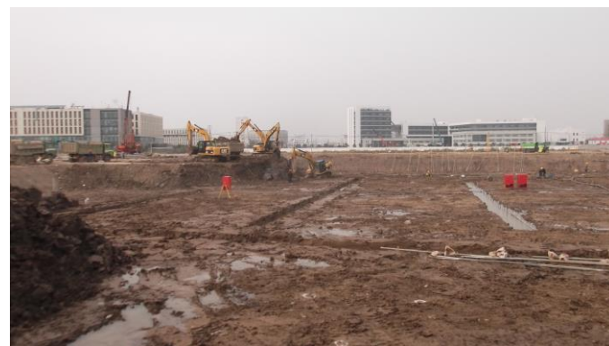
↑ 学院区大基坑东侧 (5 号块) 表层土方卸载。
