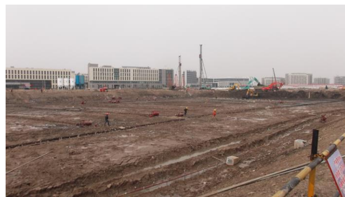
↑ 学院区大基坑西侧 (2 号块) 表层土方卸载。
