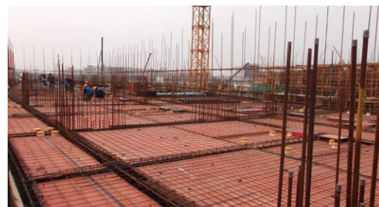
↑ 本科生宿舍 3#楼一层顶板钢筋绑扎。
