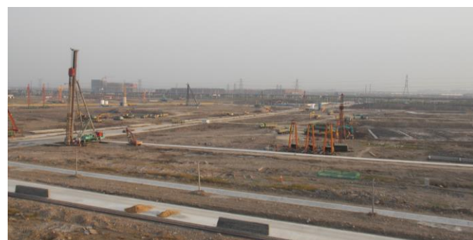
↑ 2 号块、5 号块表层土方卸载施工全景。
