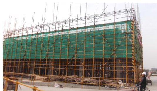
↑ 本科生宿舍 1#楼二层顶板浇筑完成。
