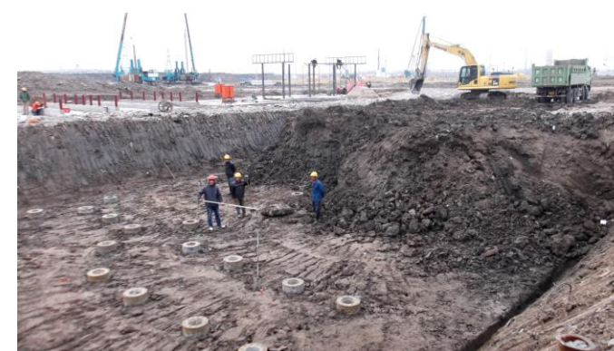
基础土方施工 ↑ 研究生宿舍 7#楼开挖。
