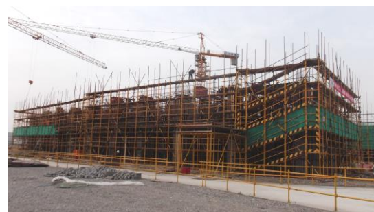
↑ 本科生宿舍 2#楼二层排架搭设。
