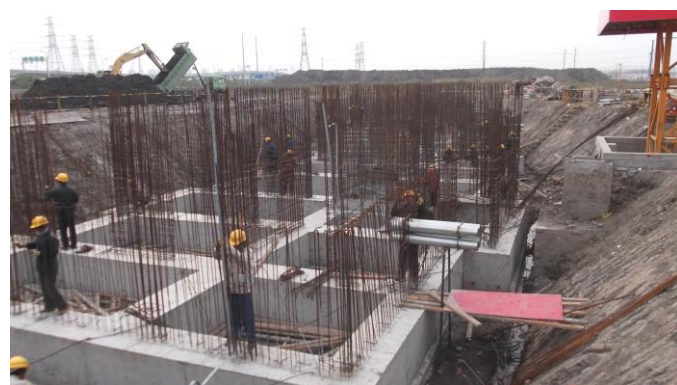
↑ 专家公寓及教师宿舍 4#楼基础剪力墙钢筋绑扎。
