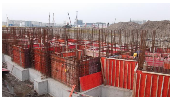
↑ 专家公寓及教师宿舍 1#楼基础剪力墙封模。
