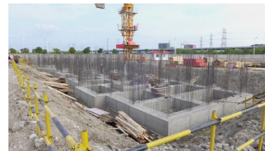
左图，专家公寓6#楼基础梁支模。右图，专家公寓3#楼已完成的混凝土基础梁。 ←（曹正梁图）
