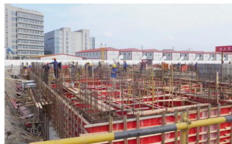
本科生1#楼基础剪力墙已完成封模。 （曹正梁图）
