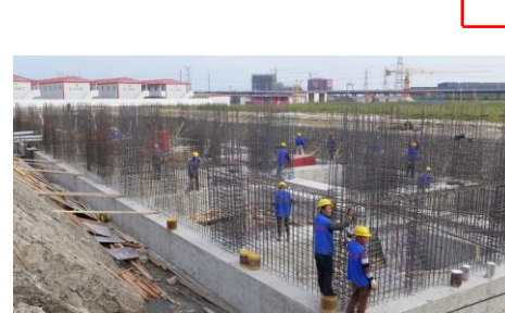
本科生3#楼开始基础剪力墙钢筋绑扎。 （曹正梁图）
