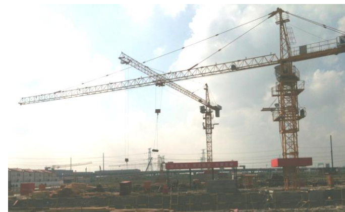
本科生宿舍楼施工现场（曹正梁图）↑
