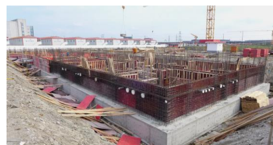
本科生2#楼基础剪力墙完成内模封闭。 （曹正梁图）
