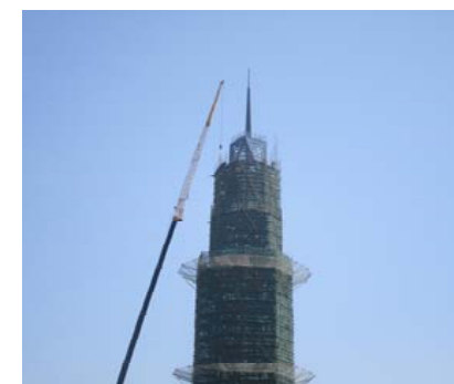
→ 图 顶层外脚手架拆卸施工
