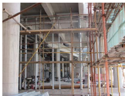
↑ 图 学生中心内部施工
