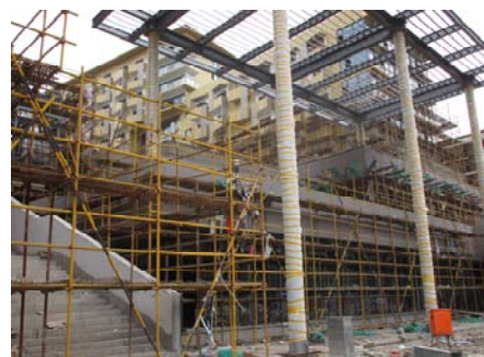
↑ 图 1 号食堂雨棚钢结构
