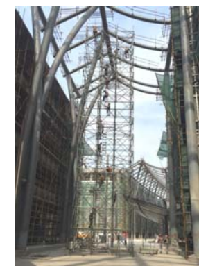
← 图 盘扣式登高脚手架 (图 孟祥鑫)
