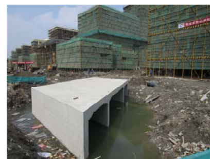
↑ 图 四号桥过水箱涵
