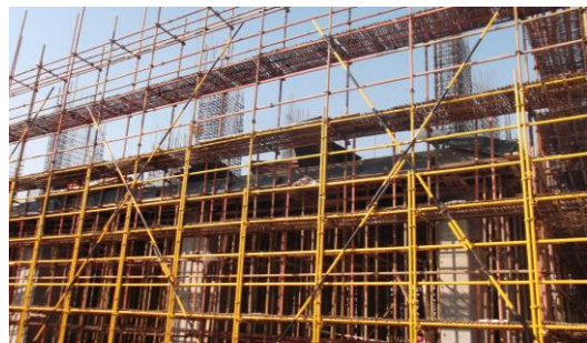
↑图 本科生宿舍 1#楼二层墙、柱钢筋绑扎。
