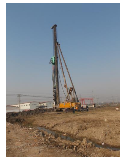
图↑ 学院区大基坑西侧止水帷幕施工。
