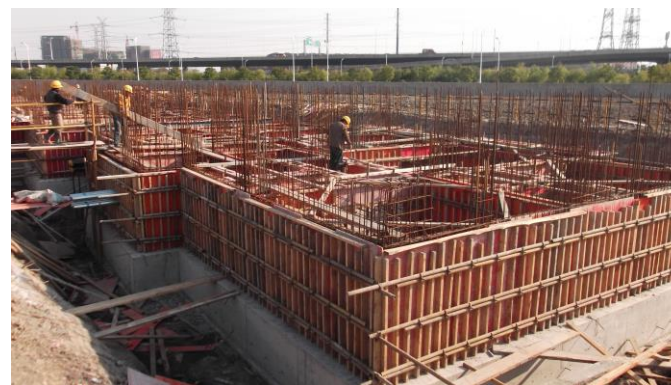
↑图 专家公寓 5#楼基础剪力墙封模。
