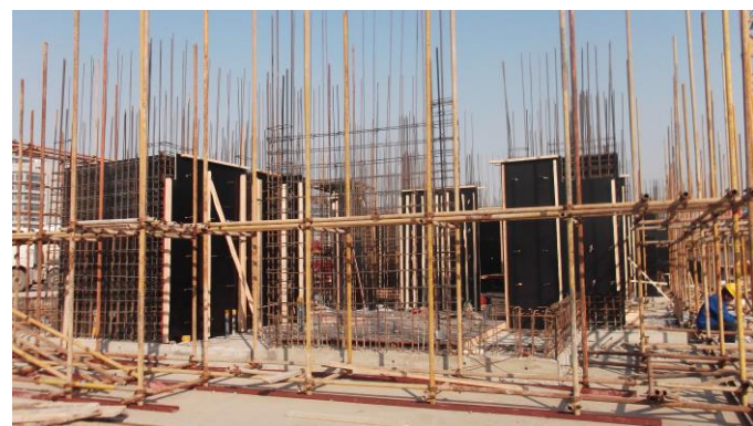
↑图 专家公寓 3#楼一层墙、柱钢筋绑扎、封模。
