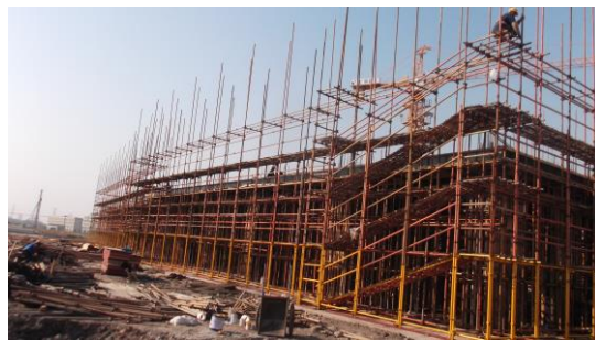
↑图 本科生宿舍 2#楼一层顶板钢筋绑扎。
