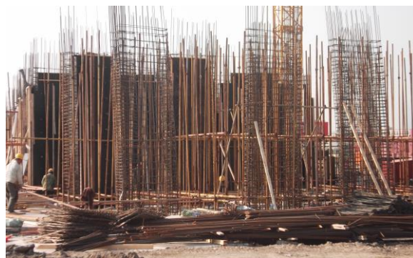
本科生宿舍 3#楼一层墙、柱钢筋绑扎、封模。 ←图
