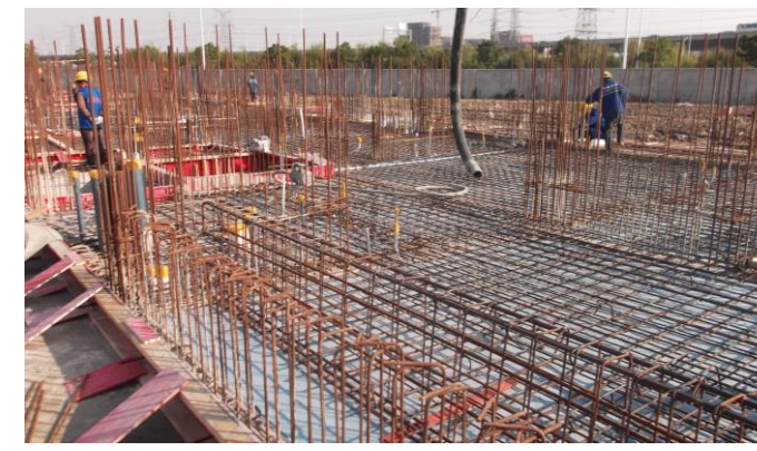
↑图 专家公寓 6#楼一层底板钢筋绑扎完成。
