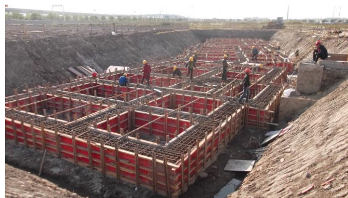
↑图 专家公寓 4#楼基础梁封模完成。
