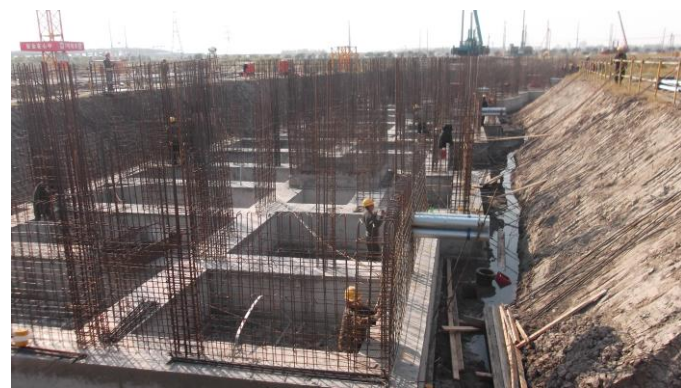
↑图 专家公寓 1#楼基础墙钢筋绑扎施工。
