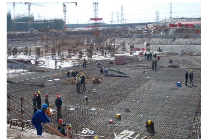
↑图 大基坑6#区域底板钢筋绑扎和地下室结构柱施工
