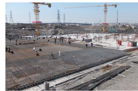
↑图 大基坑3#区域工况
