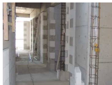
↑图 本科生宿舍1#楼二结构施工
