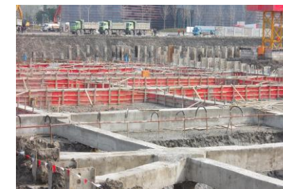
↑图 3月19日食堂支撑施工（局部）
