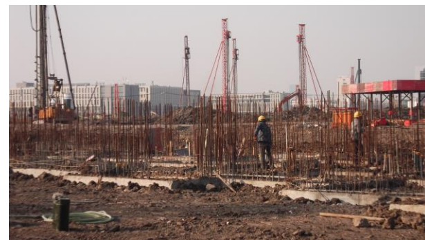
↑ 专家公寓及教师宿舍 1#楼基础回土完成
