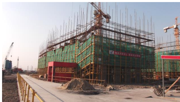
↑ 本科生宿舍 3#楼三层墙、柱钢筋绑扎
