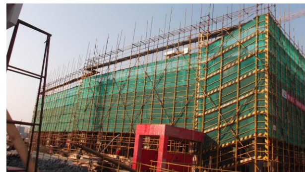
↑ 本科生宿舍 2#楼四层板钢筋绑扎
