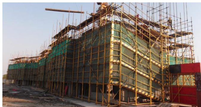
↑ 专家公寓及教师宿舍 3#楼三层墙、柱封模
