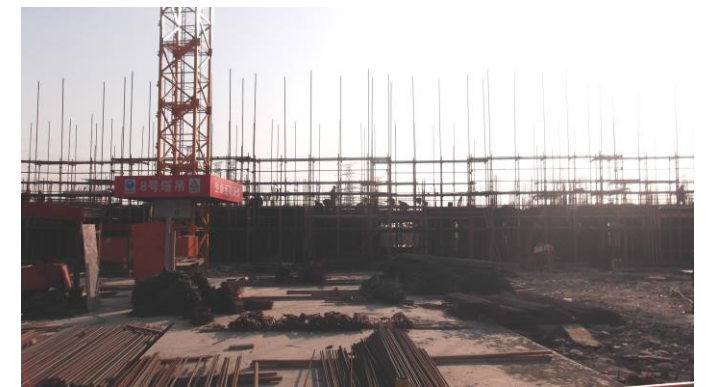
↑ 专家公寓及教师宿舍 5#楼二层板钢筋绑扎
