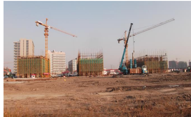
↑ 本科生宿舍 1#—3#楼施工全景，图左为 1#楼、中间为 2#楼、右为 3#楼
