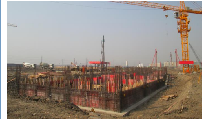
↑ 研究生宿舍 7#楼基础剪力墙梁钢筋绑扎、封模 图/孟祥鑫 (12月11日摄)
