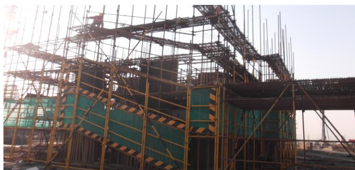
↑ 专家公寓及教师宿舍 2#楼二层墙、柱钢筋绑扎
