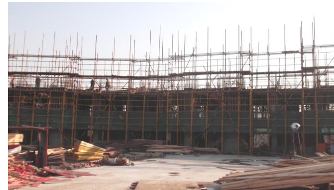
↑ 专家公寓及教师宿舍 6#楼三层板钢筋绑扎
