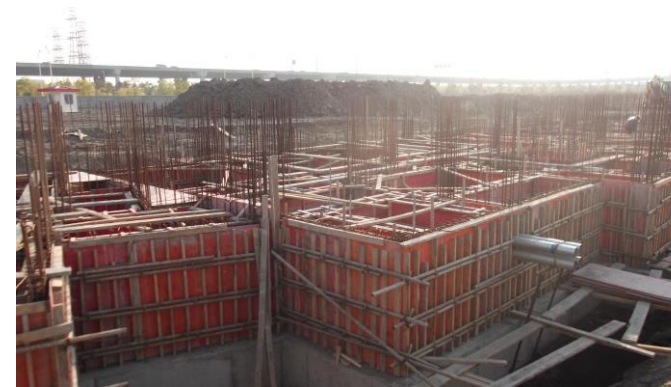
↑ 专家公寓及教师宿舍 4#楼基础墙封模完成
