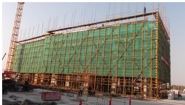
↑ 本科生宿舍 1#楼五层板钢筋绑扎
