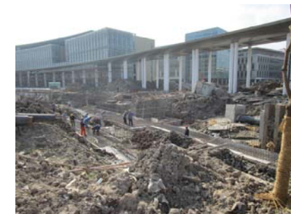
↑ 图 规一路河道档土墙施工
