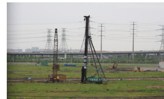
图↑ 学院区桩架拼装就位照片
