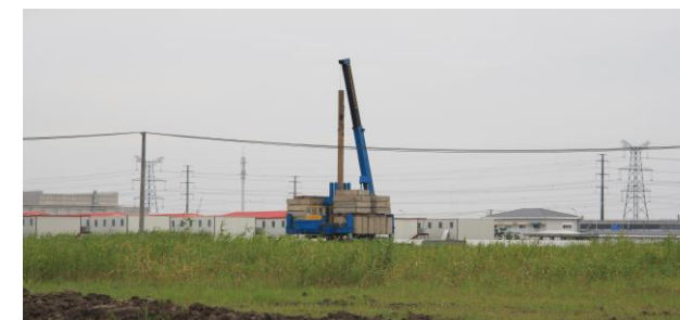
图↑ 师生生活区试桩照片
