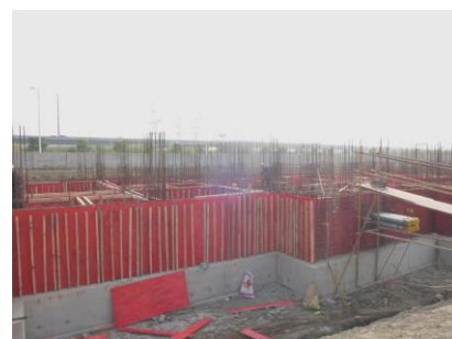
↑图 专家公寓 6#楼基础剪力墙支模
