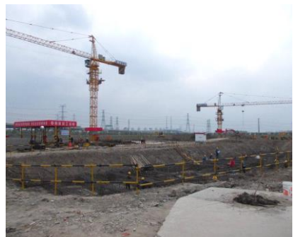
图↑专家公寓楼施工场景。
