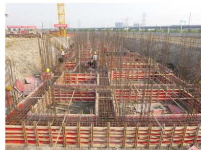
↑图 专家公寓 3#楼基础梁支模
