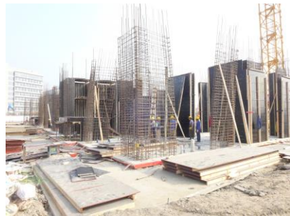
图↑本科生宿舍 1#楼一层框架钢筋绑扎，局部开始支模。
