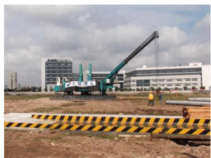
↑图 生命学院桩基施工现场。
