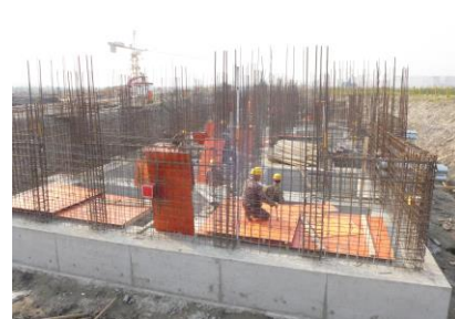
↑图 专家公寓 2#楼基础梁完
