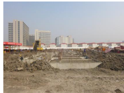
图↑本科生宿舍 2#楼土方回填施工。
