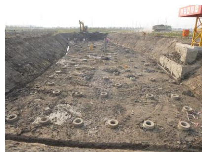
↑图 专家公寓 5#楼基坑挖土完
