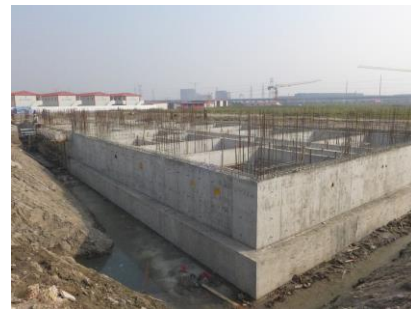
图↑本科生宿舍 3#楼基础剪力墙混凝土浇筑完成
