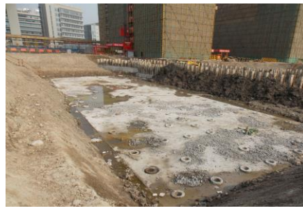
↑ 图 研究生宿舍 1#楼垫层施工完成
