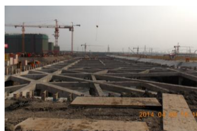
↑ 图 食堂地下室围护支撑
