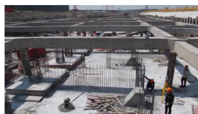
↑ 图 2#食堂部位地下室混凝土底板
