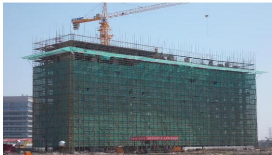
↑ 图 研究生宿舍 7#楼一结构 10 层施工
