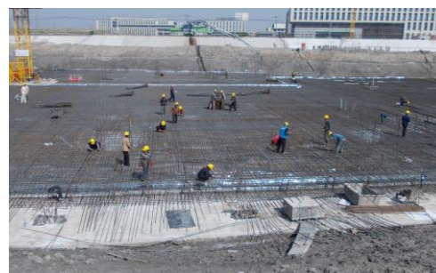
↑ 图 1-4#块底板钢筋绑扎（物质学院部位）
