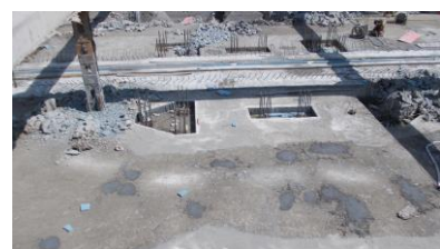
↑ 图 1#食堂部位地下室混凝土垫层
