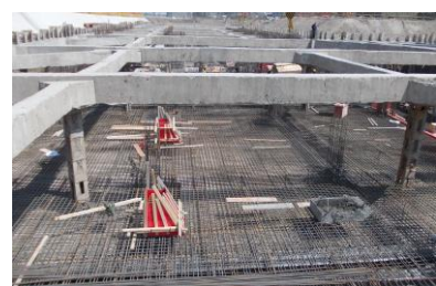
↑ 图 3#食堂部位地下室底板钢筋绑扎
