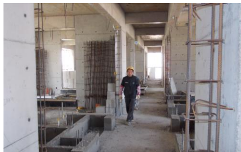
↑ 图 本科生宿舍 1#楼第 9 层二结构施工
