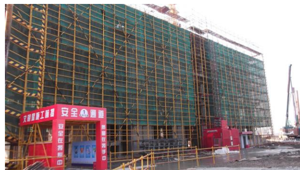
↑ 本科生宿舍 1#楼六层板浇筑完成
