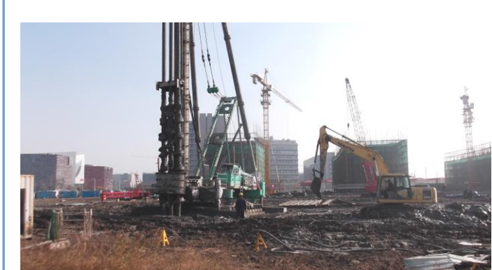
↑ 食堂基坑围护（工法桩施工）
