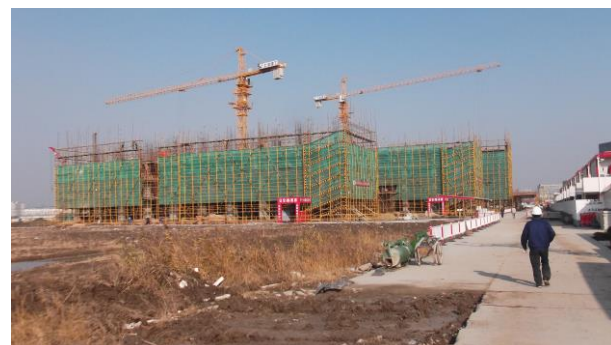
↑ 本科生宿舍 1#—3#楼施工全景
