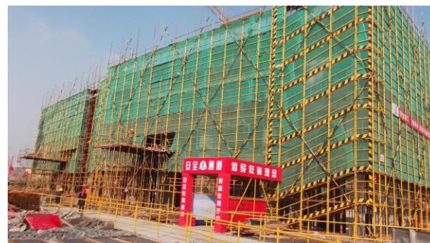
↑ 本科生宿舍 2#楼五层板钢筋绑扎
