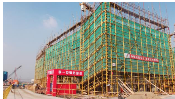
↑ 本科生宿舍 3#楼四层墙、柱钢筋绑扎
