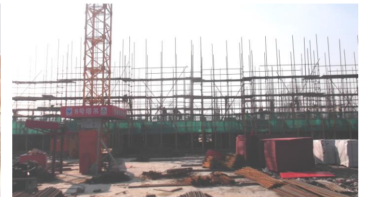
↑ 专家公寓及教师宿舍 5#楼二层墙、柱钢筋绑扎
