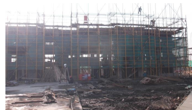
↑ 专家公寓及教师宿舍 6#楼四层板混凝土浇筑完成
