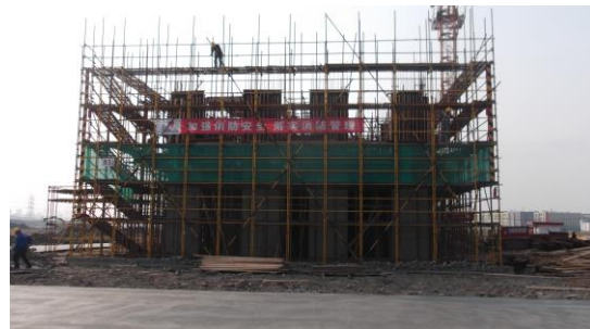
↑ 本科生宿舍 3#楼二层墙封模、脚手架搭设
