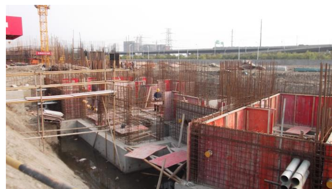
↑ 专家公寓及教师宿舍 4#楼基础墙封模
