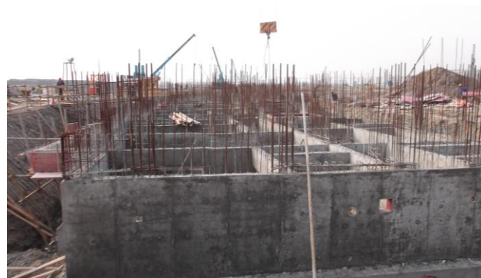
↑ 专家公寓及教师宿舍 1#楼基础剪力墙完
