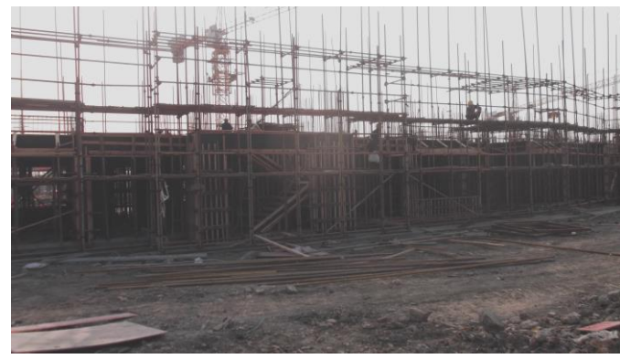
↑ 专家公寓及教师宿舍 2#楼二层板钢筋绑扎
