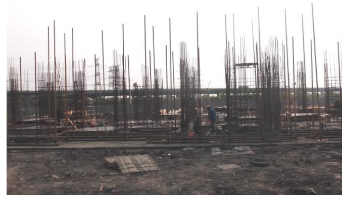
↑ 专家公寓及教师宿舍 5#楼一层框架钢筋绑扎
