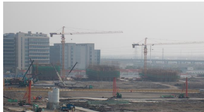
← 本科生宿舍 1# — 3#楼施工全景
