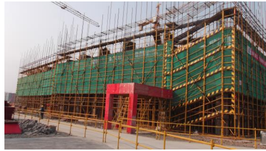
↑ 本科生宿舍 2#楼三层墙、柱封模
