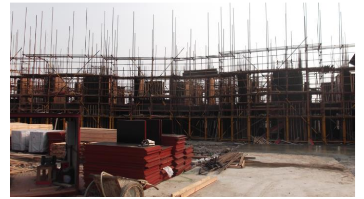
↑ 专家公寓及教师宿舍 6#楼二层墙、柱封模
