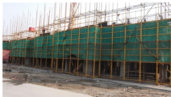
↑ 专家公寓及教师宿舍 3#楼三层板钢筋绑扎
