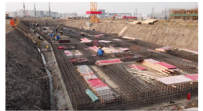
↑ 研究生宿舍 7#楼基础梁钢筋绑扎施工
