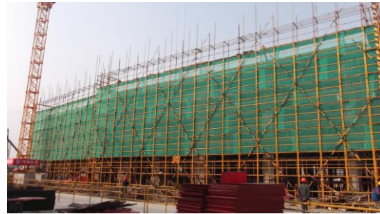
↑ 本科生宿舍 1#楼三层结构完
