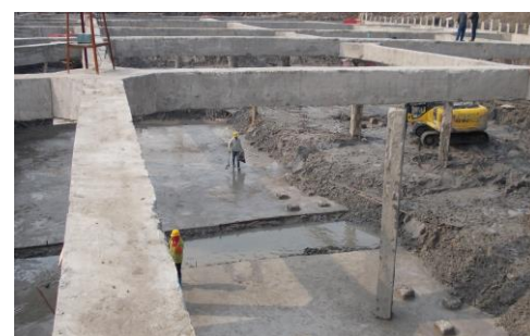
↑图 食堂部分垫层浇筑完成
