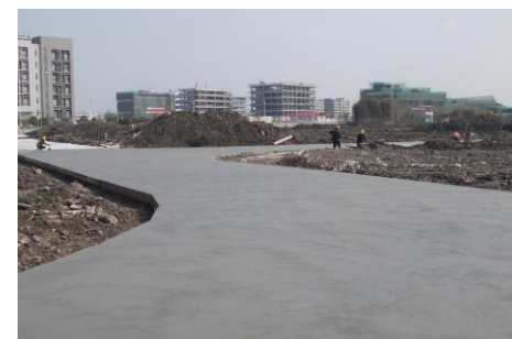
↑图 国际交流中心便道施工
