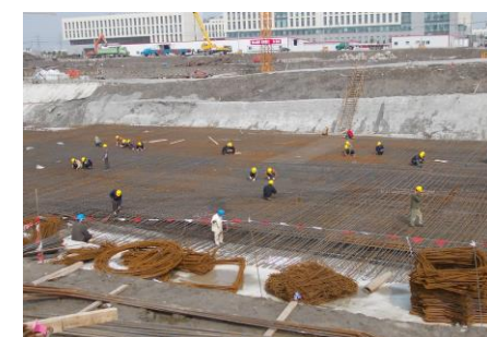
↑图 7-3#块底板钢筋绑扎
