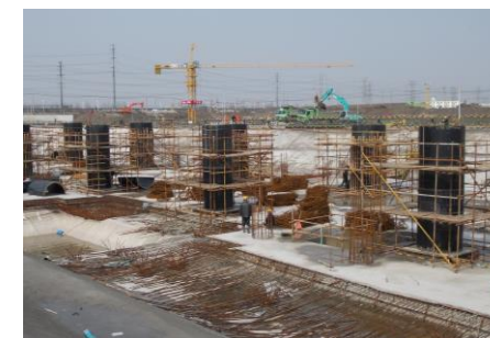
↑图 2#区域地下室结构柱施工
