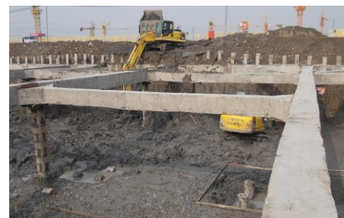
↑图 3#食堂区域挖土
