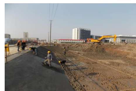
↑图 生命学院土方卸载、基坑护坡
